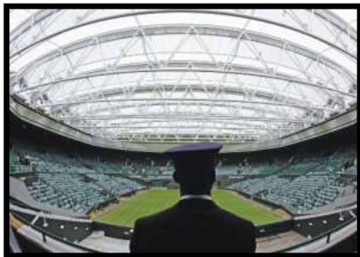
Известно также раздвижное покрытие, которое снабжено раздвижными секциями и их приводом, принятое нами за прототип.
